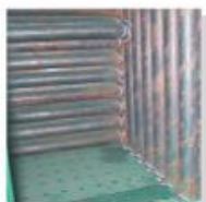
Structură din elemente de țevă de oțel cu focar spațios
