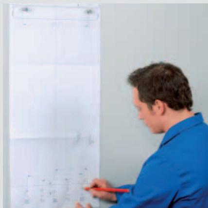
1. Pregătirea montajului cu ajutorul sablonului
